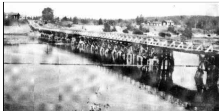
Saksalaisten rakentama ja lähtiessään räjäyttämä pukkisilla.
